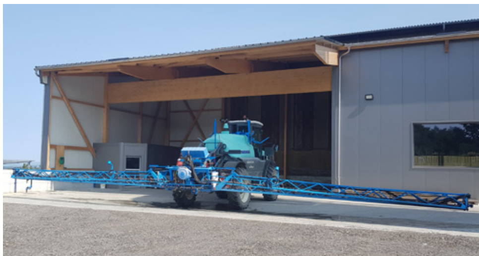
Installation de traitement des effluents phytosanitaires.
